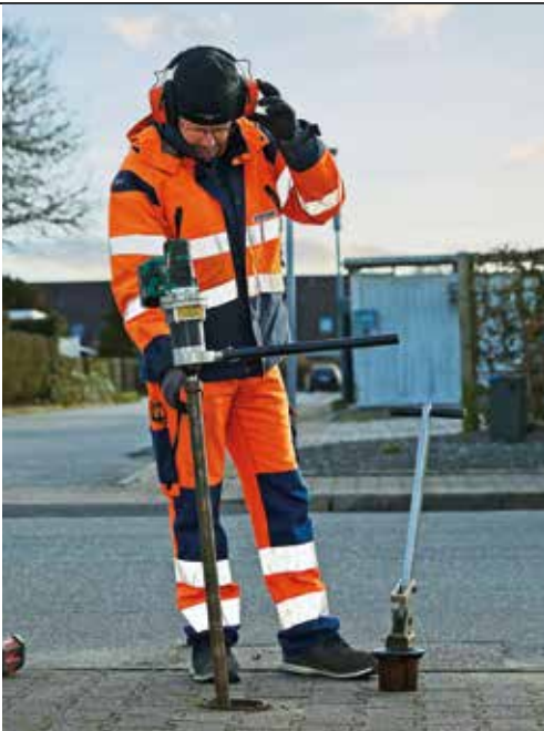
Drikkevandsselskaberne "lytter på vandrørerne" for at finde utætheder. Foto: EWII
