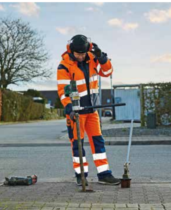
Sektionsopdeling af ledningsnettet og fjernaflæste målere gør det nemmere og hurtigere at finde lækager. Foto: EWII
